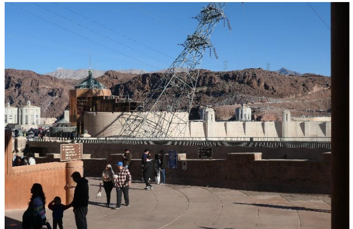
ダム下流斜面に斜めに建てられた送電鉄塔
