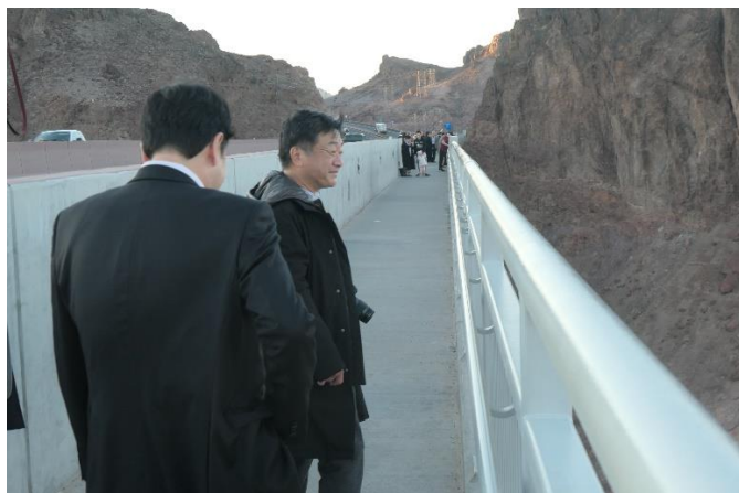
コロラド川橋梁に併設された観光用の歩道
