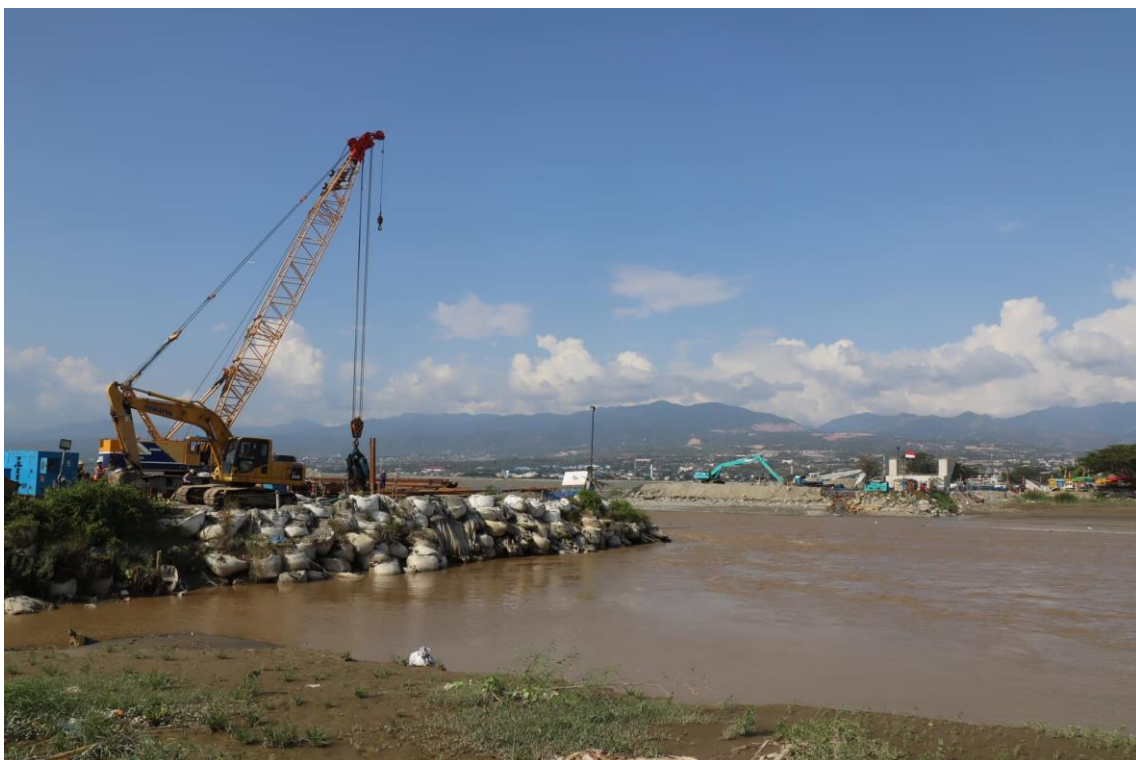
パル第4橋再建工事の状況
