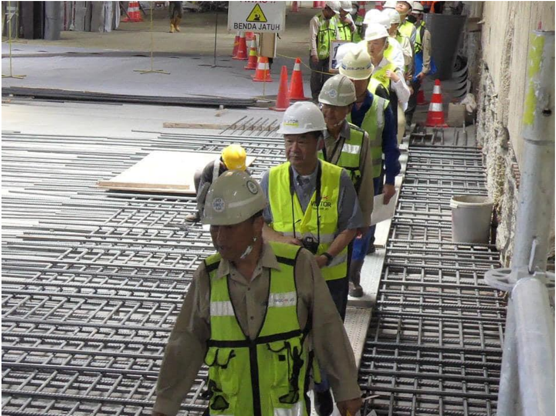
Glodok駅工事現場の調査状況
