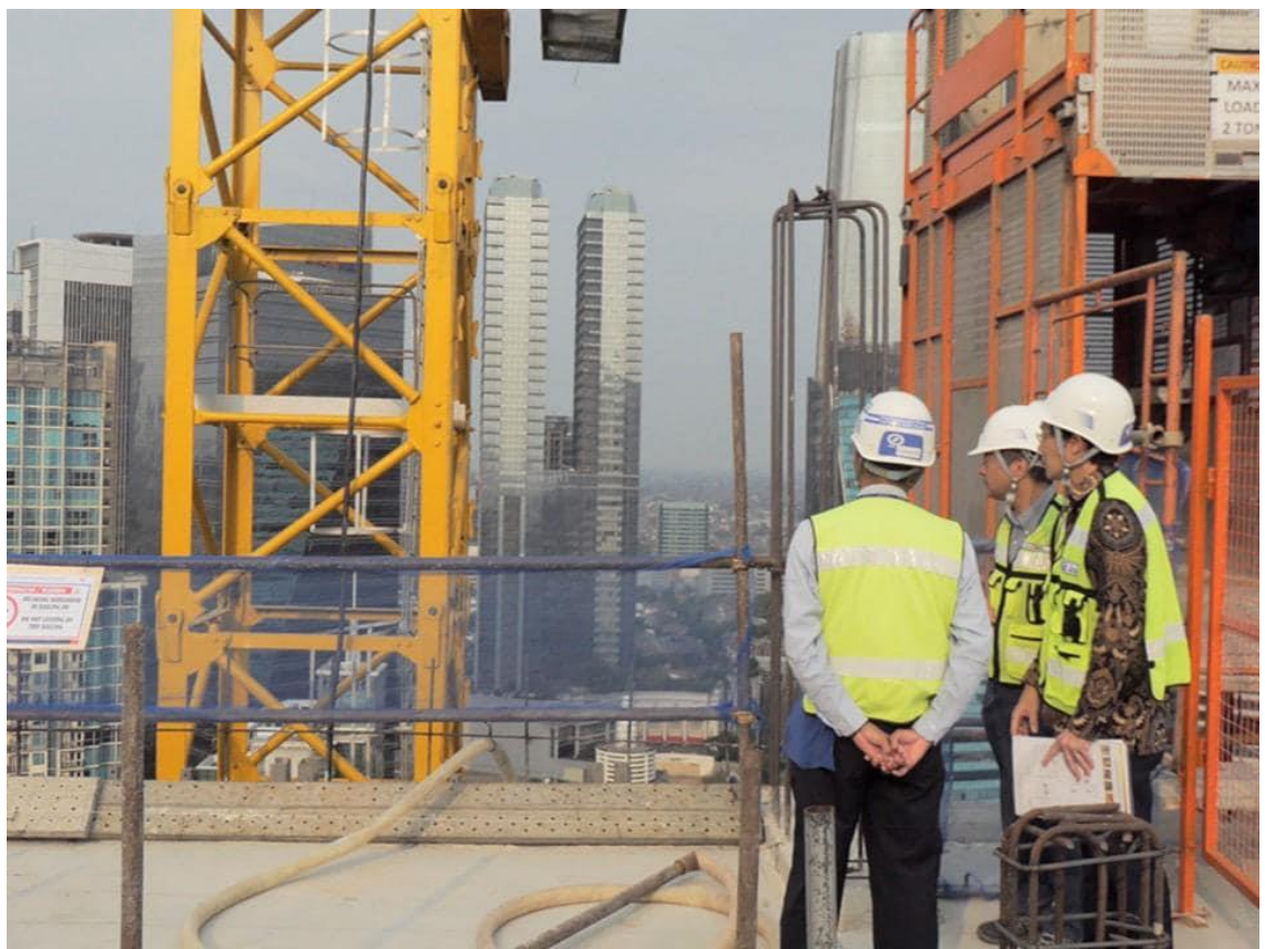
建設中のビル屋上での調査状況
