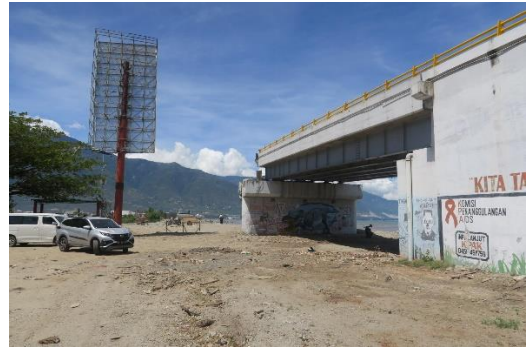
橋梁の残存部分
