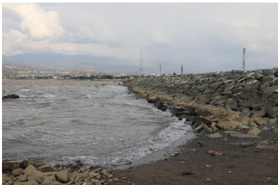
嵩上げされた海岸堤防
