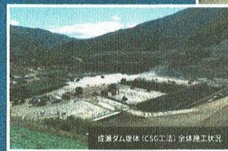
成瀬ダム堤体（CSG工法）全休施工状況
