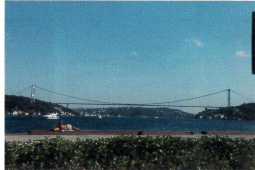
第1ボスポラス橋
