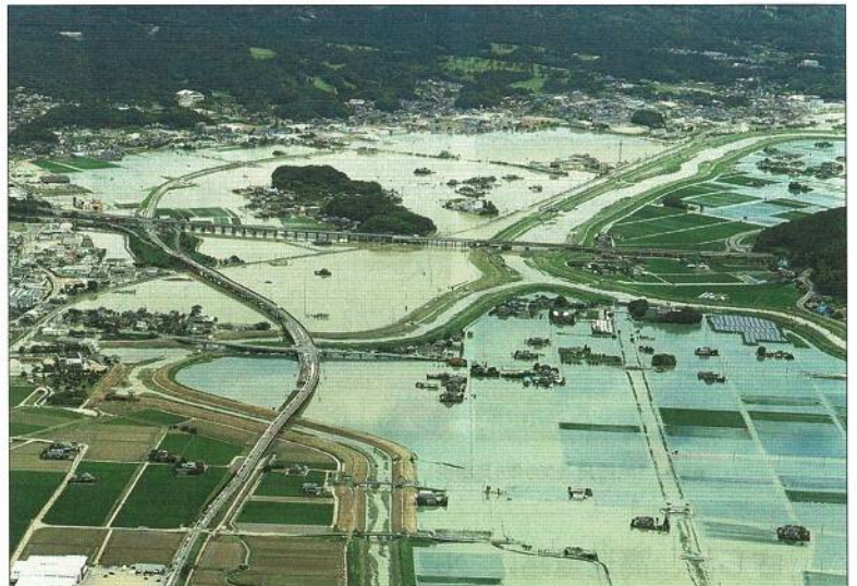
令和3年8月大雨災害 佐賀県六角川（令和3年8月15日撮影） 一般社団法人 全国測量設計業協会連合会加盟 国際航業(株)・(株)パスコ共同撮影
